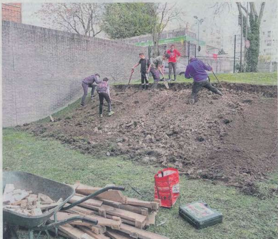
Le chantier du théâtre en plein air se poursuivra la semaine prochaine sous la houlette d'Étienne Desjonquères, le directeur du centre culturel. (Photo : Centre culturel J. Tati)
